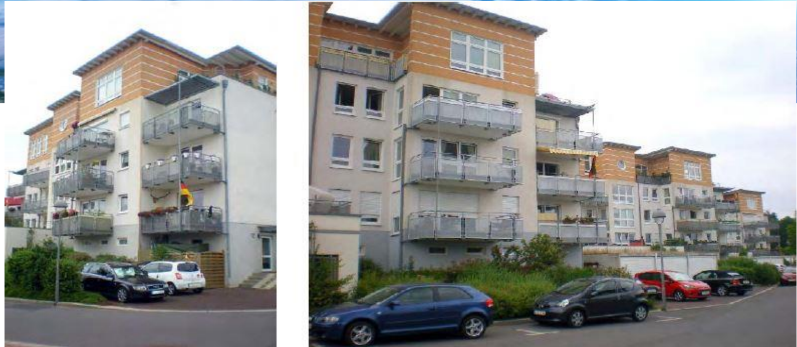
Ref 12 | 45 ETW Mängelverfolgung und Gewährleistungsmanagement, Lüdenscheid NRW
